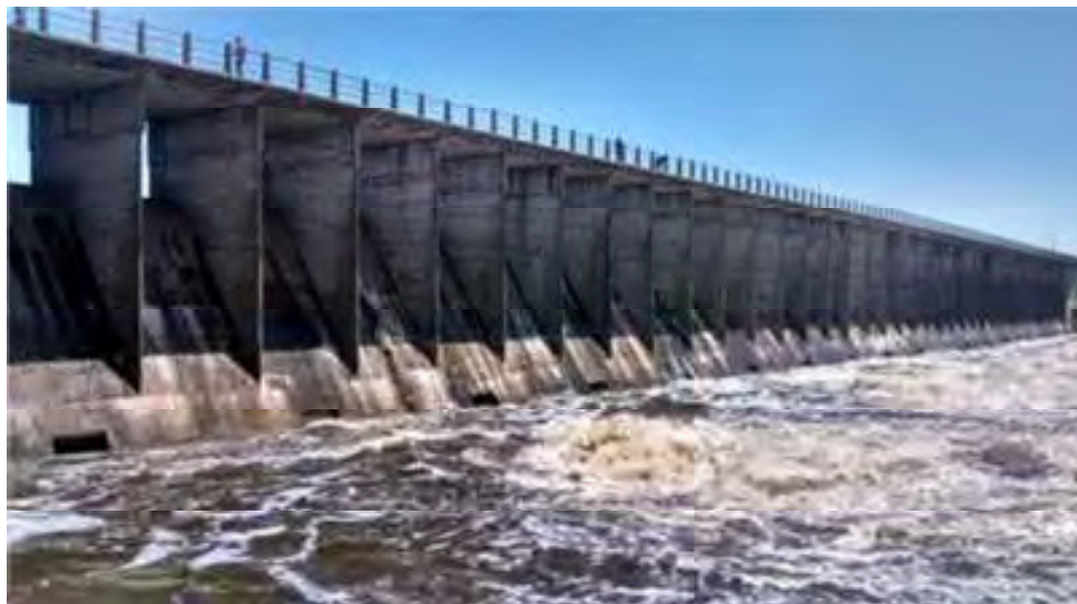
Figura 9: Presa Ingeniero Carlos Roggero 18 .
